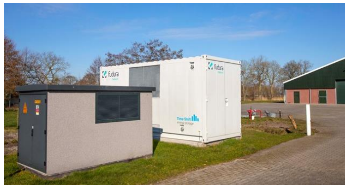
Batterijen voor opslag van elektriciteit
