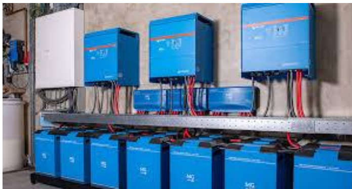
Batterijen voor opslag van elektriciteit
