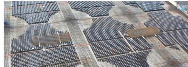
Dalle avant coulage béton
