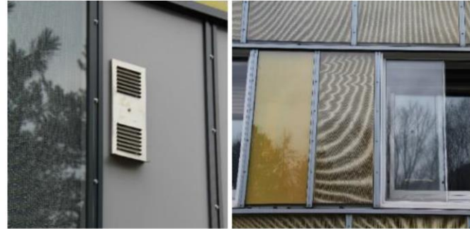
Zichtbare (links) of achter glas ingewerkte ventilatieopeningen (rechts)
