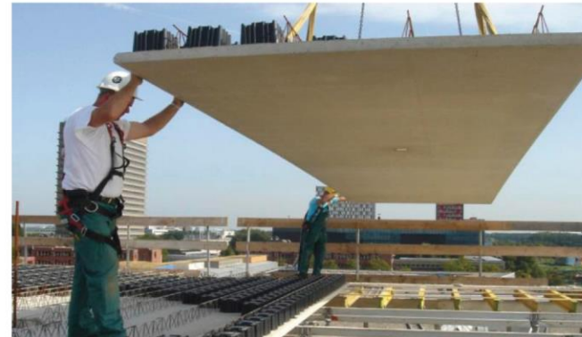
Pré-dalle pré-équipées des coques
