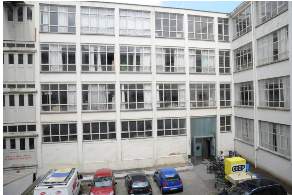
Bedrijvencentrum Scheikundige/Chimiste – TV STABO/archipelago architects
